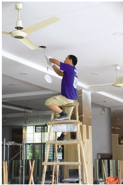
食堂维修改造中
