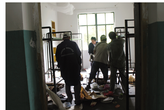
进行宿舍楼改造前腾空工作
