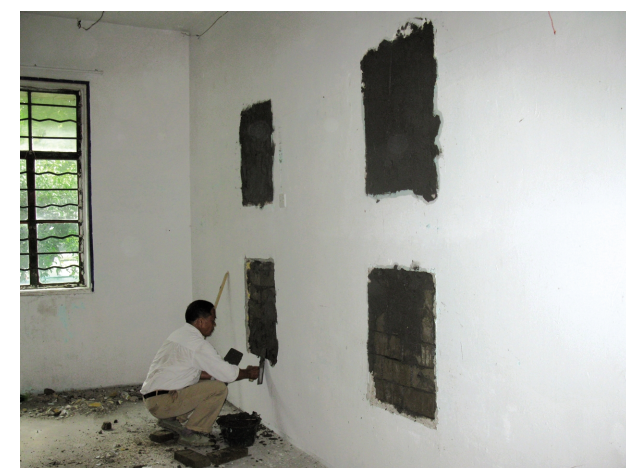
宿舍内改造维修
