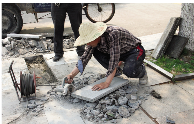
春华苑广场路面修缮
