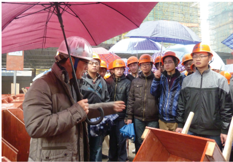
12月20日,建筑工程学院组织300余名大一新生到嘉兴万科、上海家树、上海新联康三家企业进行专业认知实践。图为同学们在参观万科工程项目的施工现场。白会民 摄
